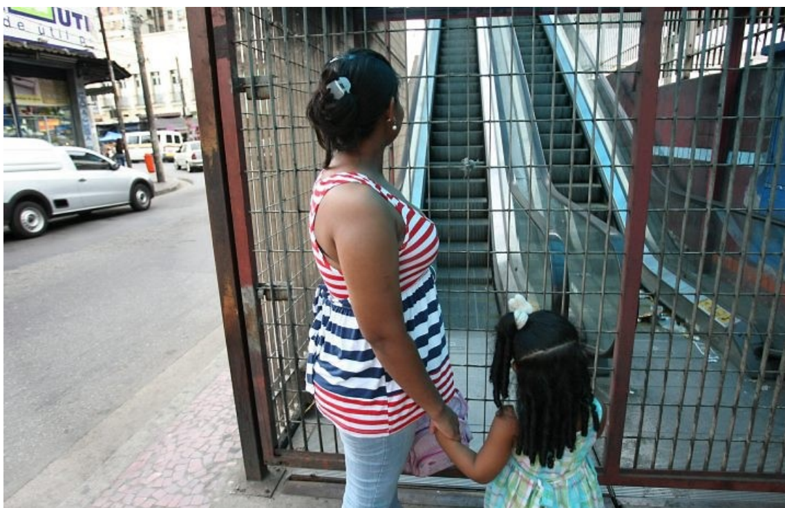
Figura nº 3 Escadas rolantes da SuperVia com defeito. Estação Madureira. Na foto, o acesso a escada rolante fechado.
